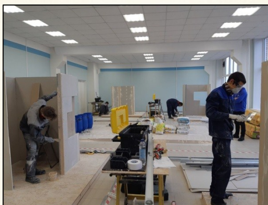
Сухое строительство и штукатурные работы
